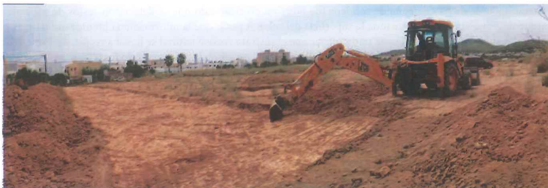
Imagen del solar mientras se realizaban los trabajos de excavación del nivel superficial con medios mecánicos
