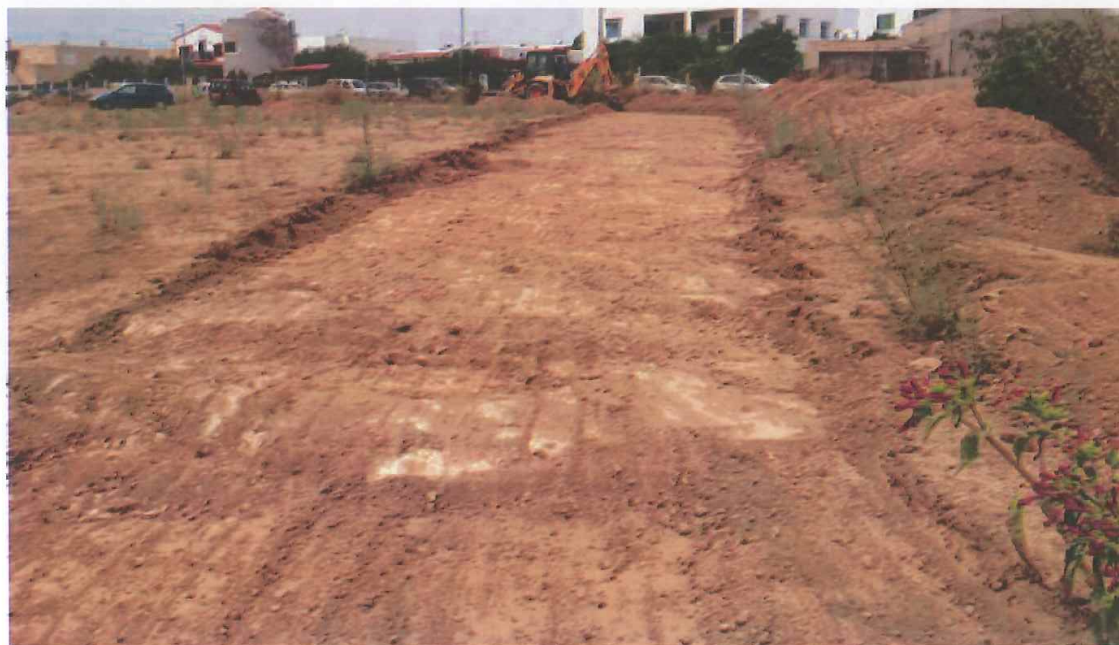
Imagen de la máquina retirando el nivel superficial, UE 01 y 02
