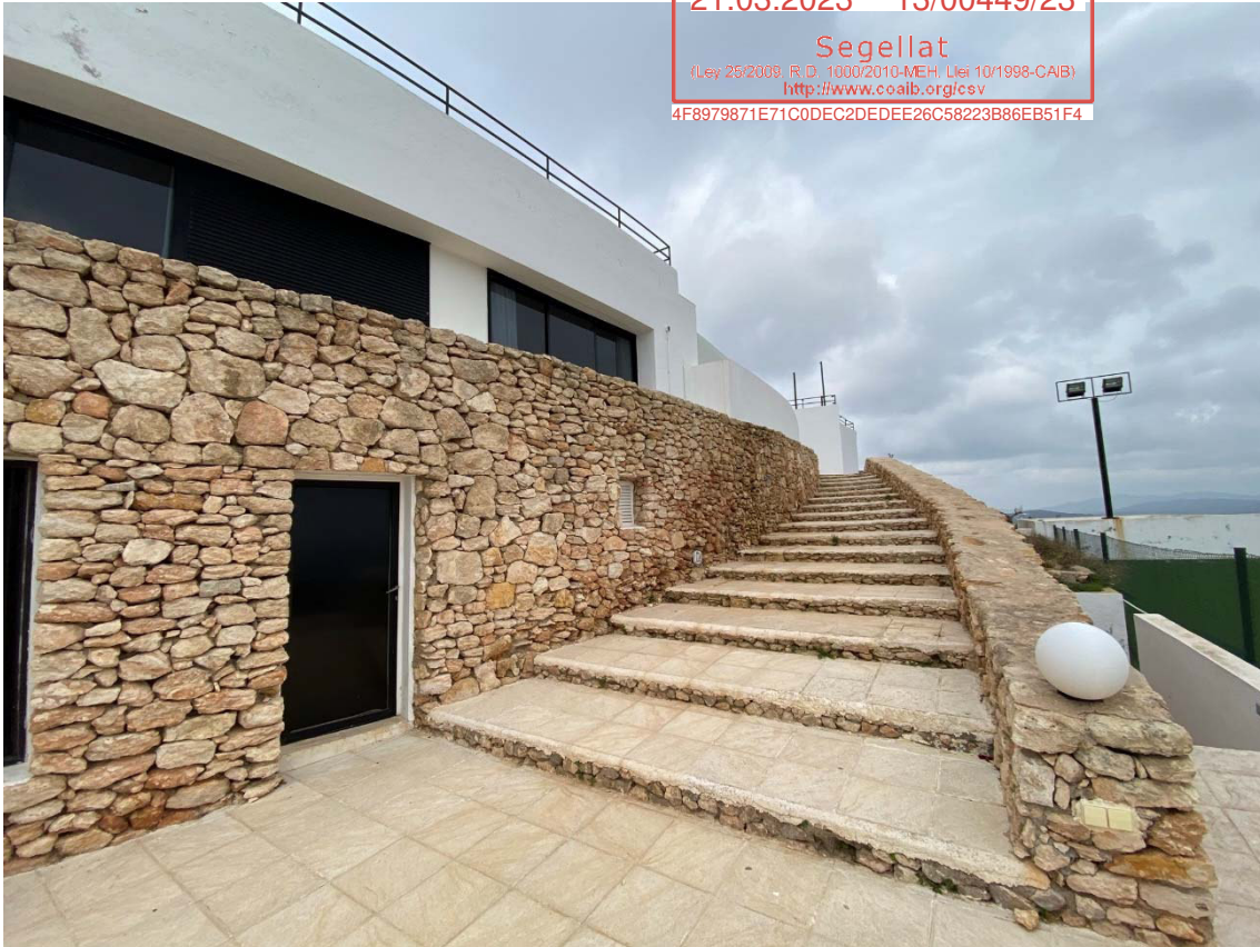
Acceso de nivel -1 a nivel 0
