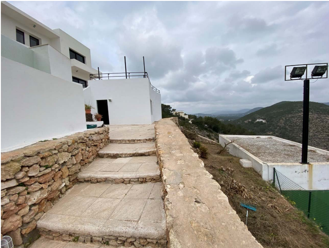
Acceso de nivel -1 a nivel 0
