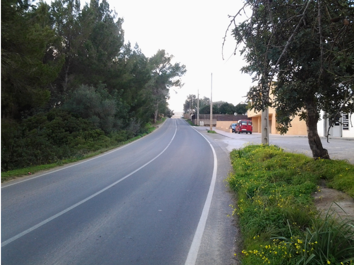
Foto 5. Detalle de la isleta de separación.
