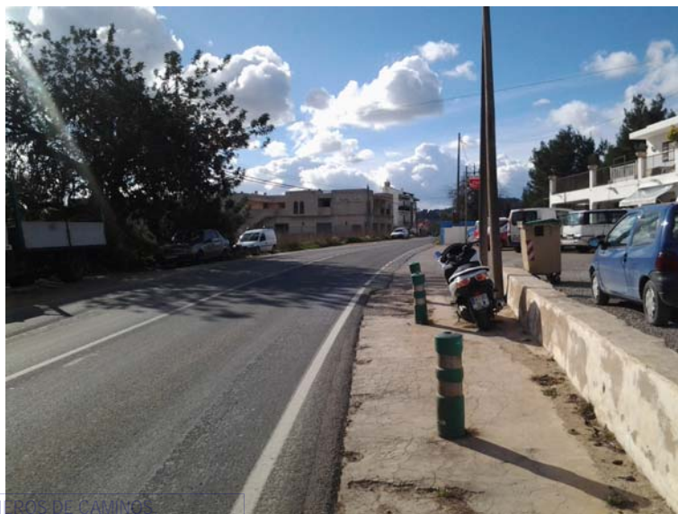
Foto 18. Vista del punto donde el muro se abre un poco, termina, y empiezan los accesos desordenados.
