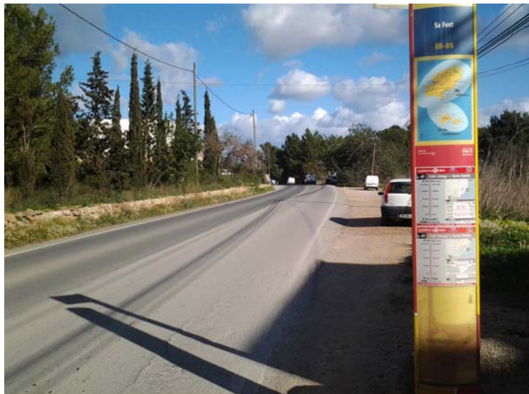
Foto 26. Parada bus existente dirección Santa Eulària. Más adelante se observa espacio para nueva situación parada de bus.
