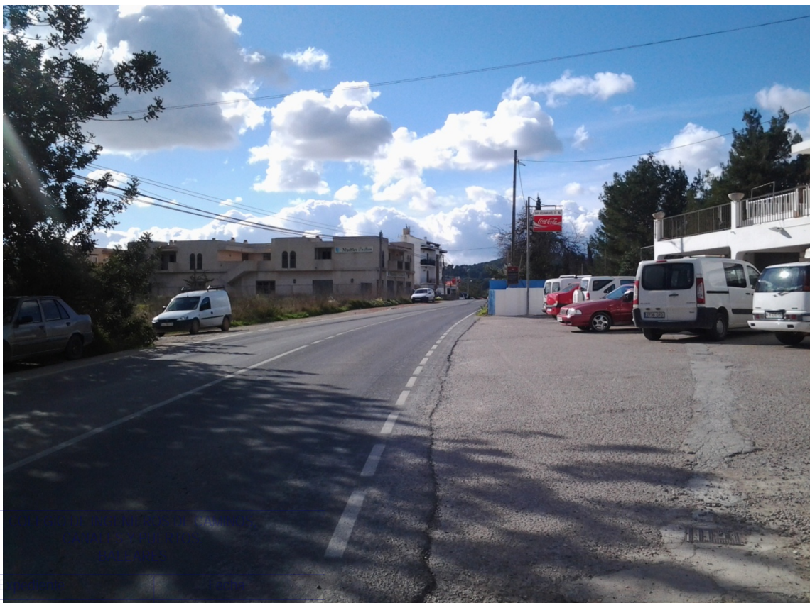
Foto 16. Vista de los accesos desordenados al edificio de bar y locales.
