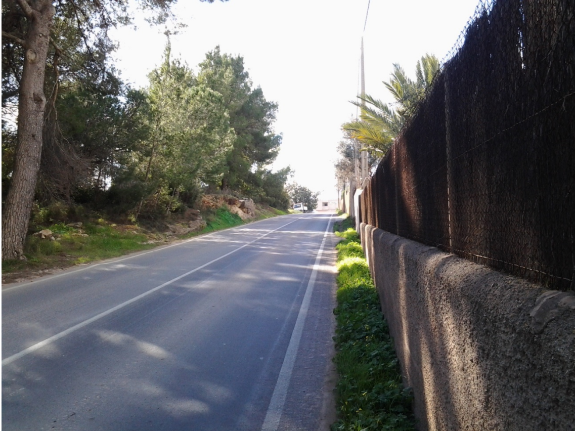
Foto 11. Detalle arcén y cuneta entre carretera y muro existente.
