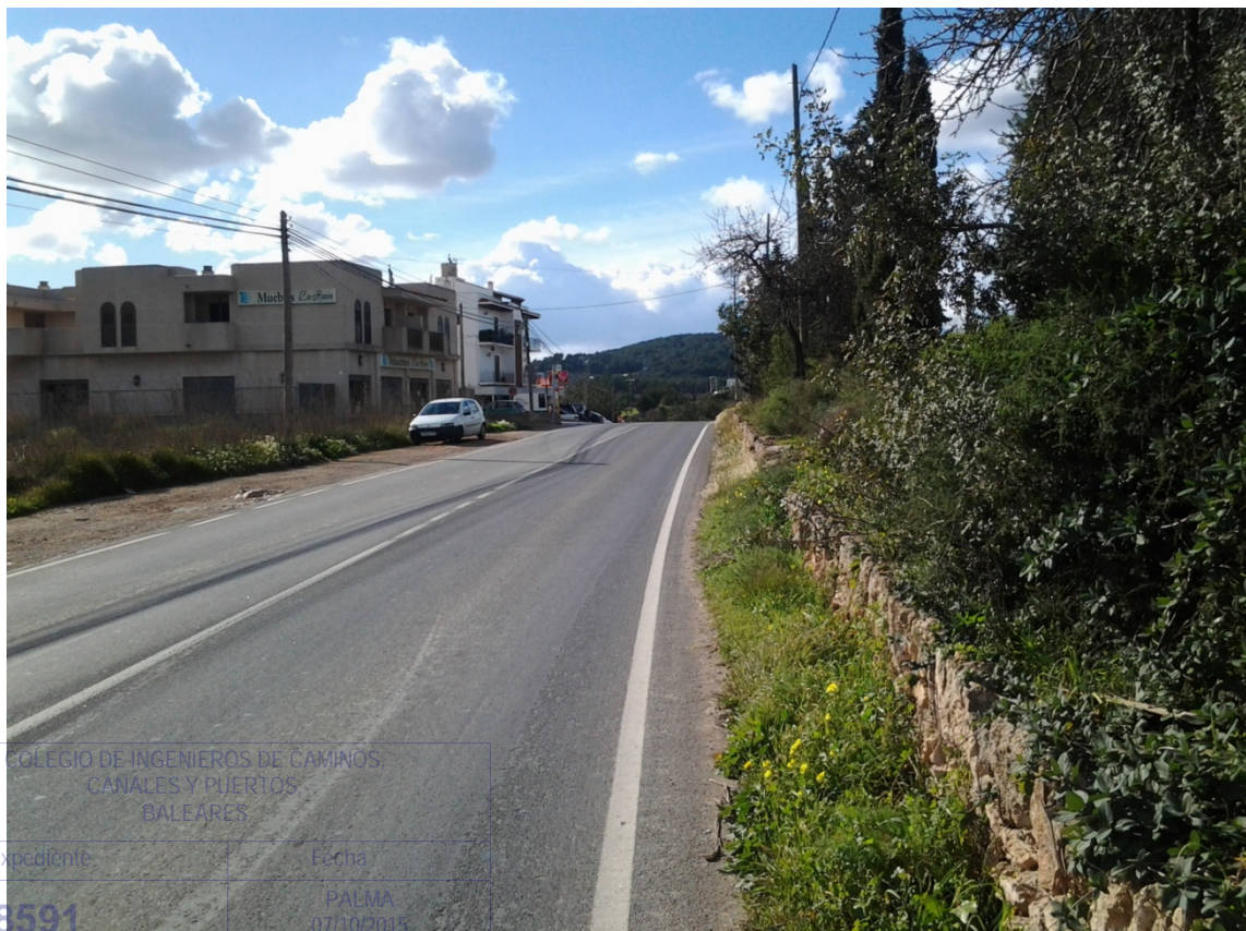
Foto 20. Detalle murete de piedra seca anejo a cuneta norte de la carretera.
