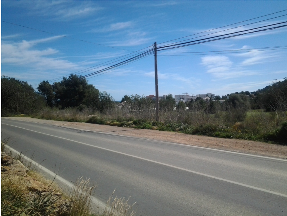
Foto 29. Vista sobrelancho en tierras lado sur carretera. Espacio para nueva parada bus.
