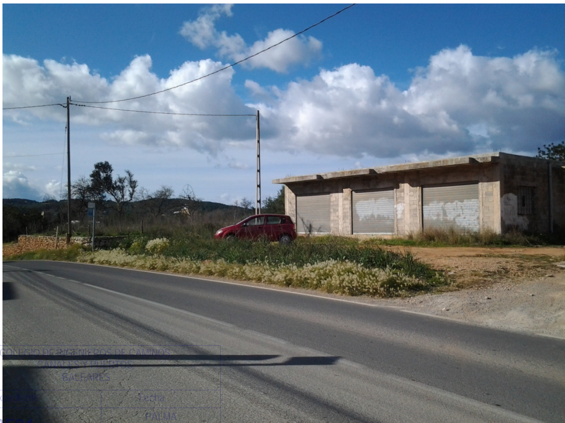
Foto 24. Vista de garaje en lado norte de la carretera.
