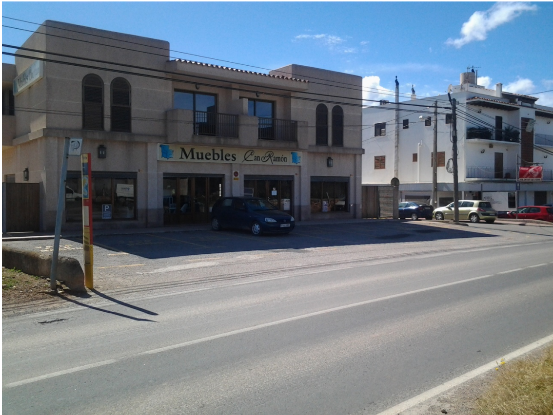
Foto 27. Accesos directos desde carretera a aparcamiento tienda de muebles.
