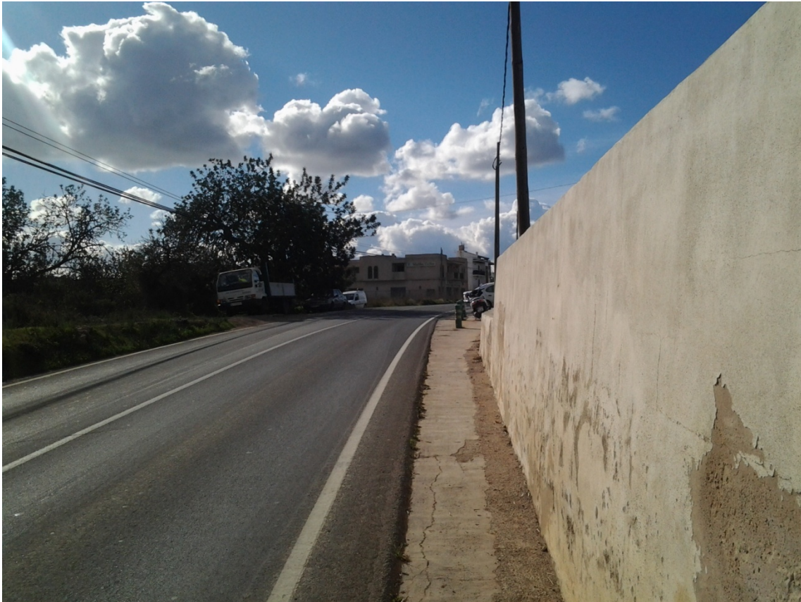
Foto 17. Vista del muro en lado norte de la carretera.
