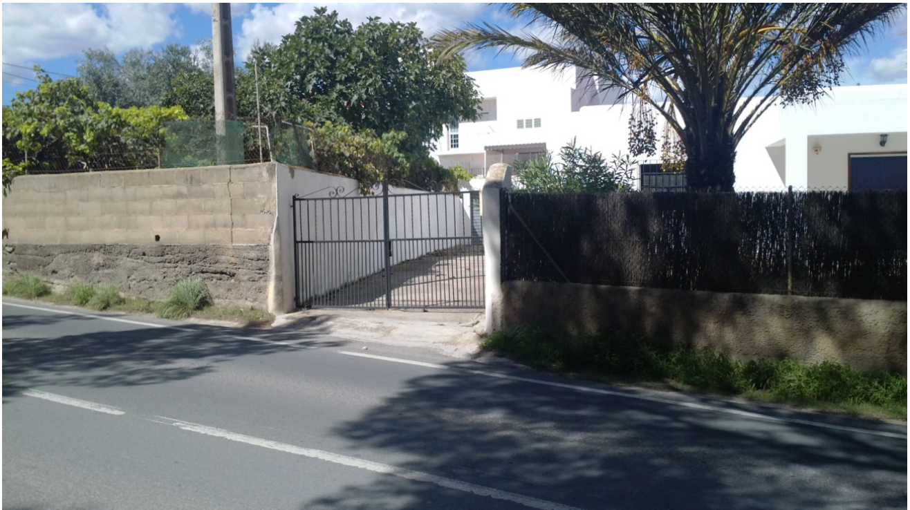
Foto 5: Vista de la puerta de acceso, muro y valla de cerramiento existentes.
