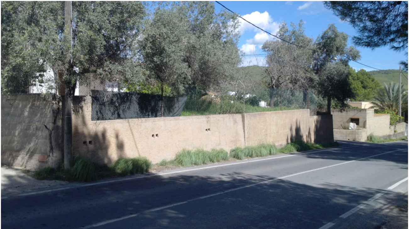
Foto 3: Vista del muro, valla y arbolado existentes.
