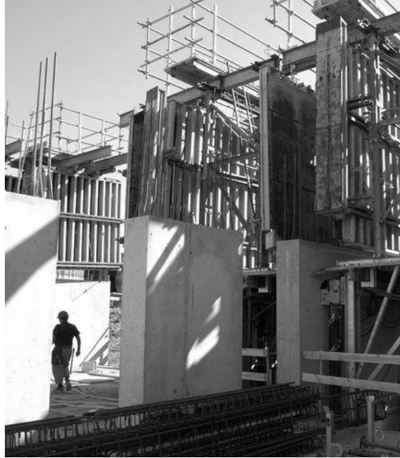
Ejemplo de soportes mediante pantallas. Edificio Torre Lugano. Benidorm.
