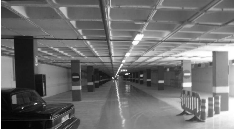
Forjado reticular de casetón recuperable. Parking en la calle López de Osaba. Alicante.
